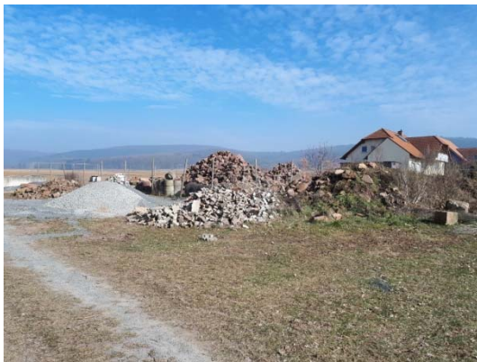
Geplantes Bauhofgelände, nördlicher Abschnitt
